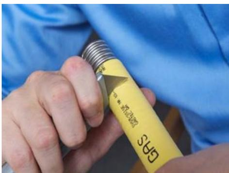
Couper avec un cutter sur une longueur d'environ 2,5 à 3 cm, la gaine en polyéthylène. **Attention : le cutter ainsi que la coupe du tube PLT sont tranchants. Soyez prudent lors de la coupe et lors de la manipulation du bout de tuyau.**
